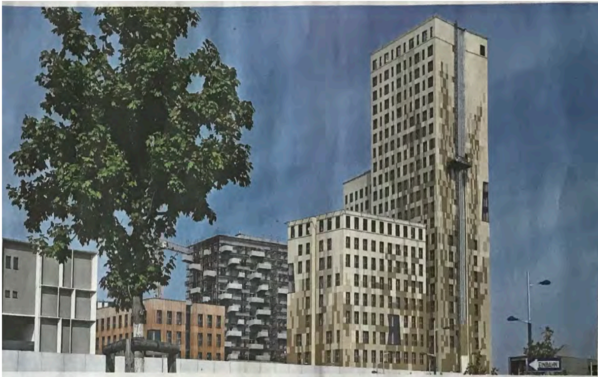
Abbildung 4: Bürokomplex im Wiener Stadtteil Aspern, hier wurden Stahlbeton und Zement weitestgehend durch Holz ersetzt Foto: F.A.Z.
