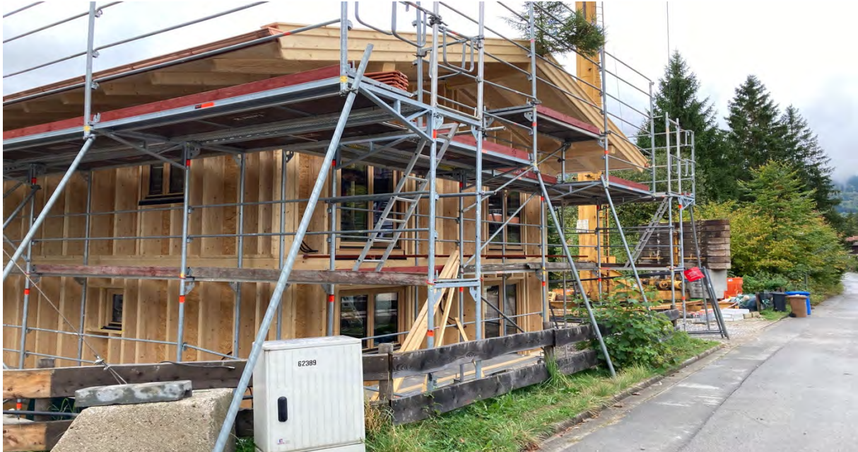
Abbildung 5: hochgedämmtes Einfamilienhaus in Ständer-Fachwerk-Bauweise; für den Hausbau benötigt man Nadelholz, z.B. Fichte, Weißtanne, Douglasie Foto: H.-U. Dombrowsky
